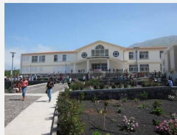
Lycée de Ponta Verde sur l'île de Fogo, construit par la Coopération luxembourgeoise et entré en fonction pour la rentrée 2013/2014
